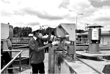
Nhân viên Nhà máy xử lý nước thải tập trung KCN Đông Xuyên kiểm tra hệ thống quan trắc tự động.
